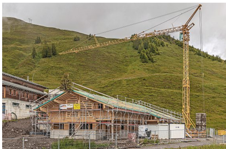
Das neue Bergrestaurant auf Käserstatt befindet sich im Bau.
