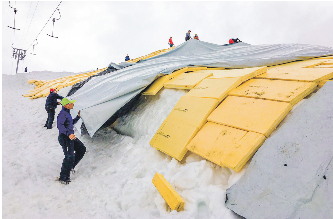
Der während des Winters eingelagerte und übersommerte Schnee konnte nun «geerntet» und zur einer Piste verarbeitet werden.
